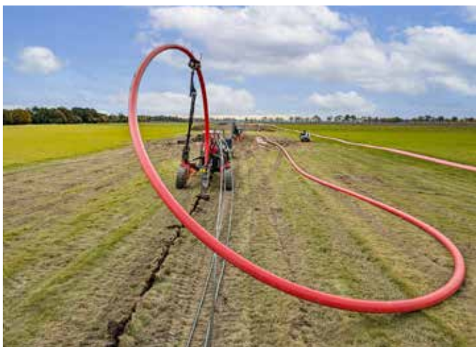
Im Rheiderland wurden 250 km Höchstspannungsleitungen minimalinvasiv verlegt. Fotos: Frank Föckersperger GmbH
