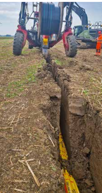
Das Pflugschwert kann bis zu 3,50 m Tiefe ausgefahren werden.
