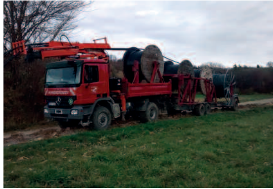
Kabeltransport mit vier Trommeln.
