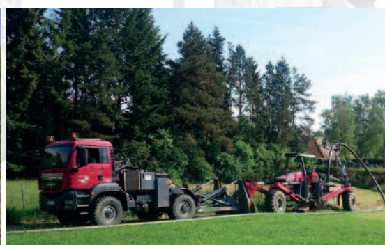
Einpflügen einer Abwasserdruckleitung PE-HD DA 160.
