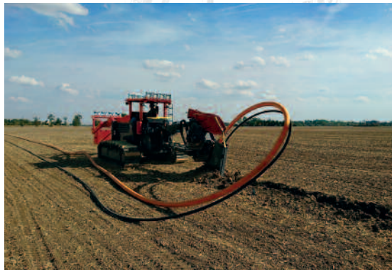
Einpflügen einer Gasleitung PE-HD DA 110 und KSR DA 50.
