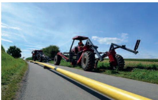
Einpflügen einer Stahlgasleitung DN 150 mit dem Raketenspflug®.
