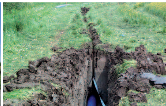
Oberfläche nach der Verlegung einer Trinkwasserleitung 250 x 14,8 mit dem Raketenspflug®.
