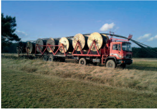
Kabeltransport mit sieben Trommeln.
