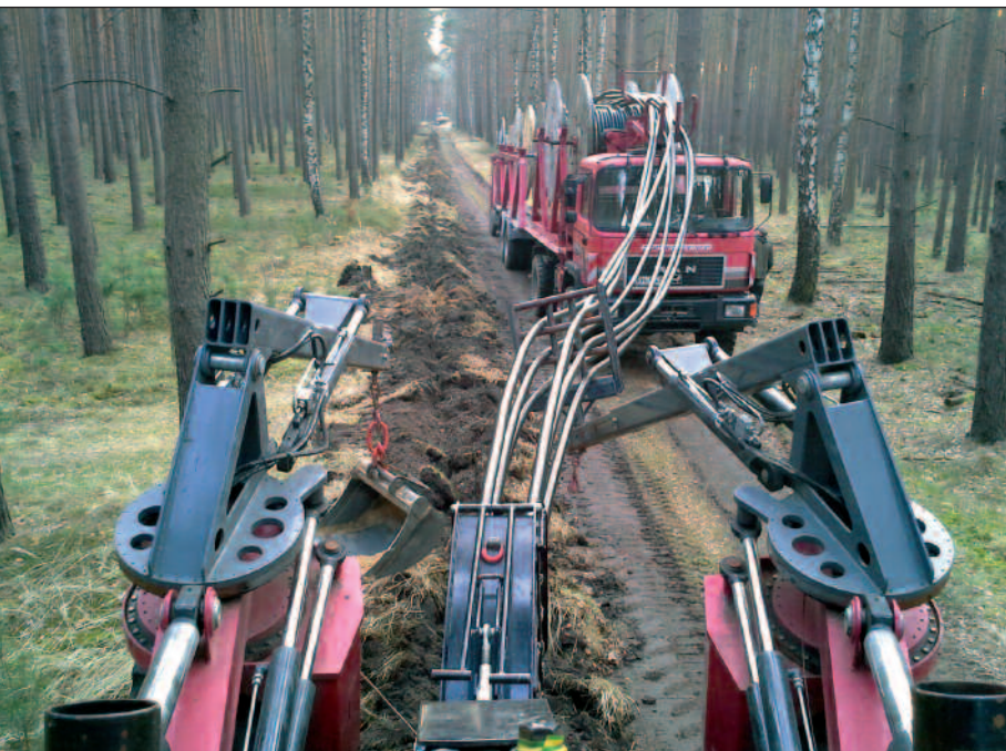
Gleichzeitige Verlegung von zwei Mittelspannungssystemen nebeneinander.
