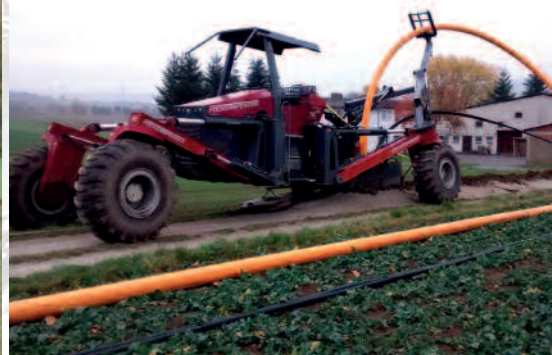
Einpflügen einer Gasleitung PE-HD DA 180 und 2 x KSR DA 50.
