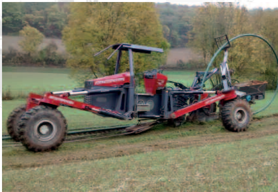
Einpflügen einer Abwasserdruckleitung PE-HD DA 90.
