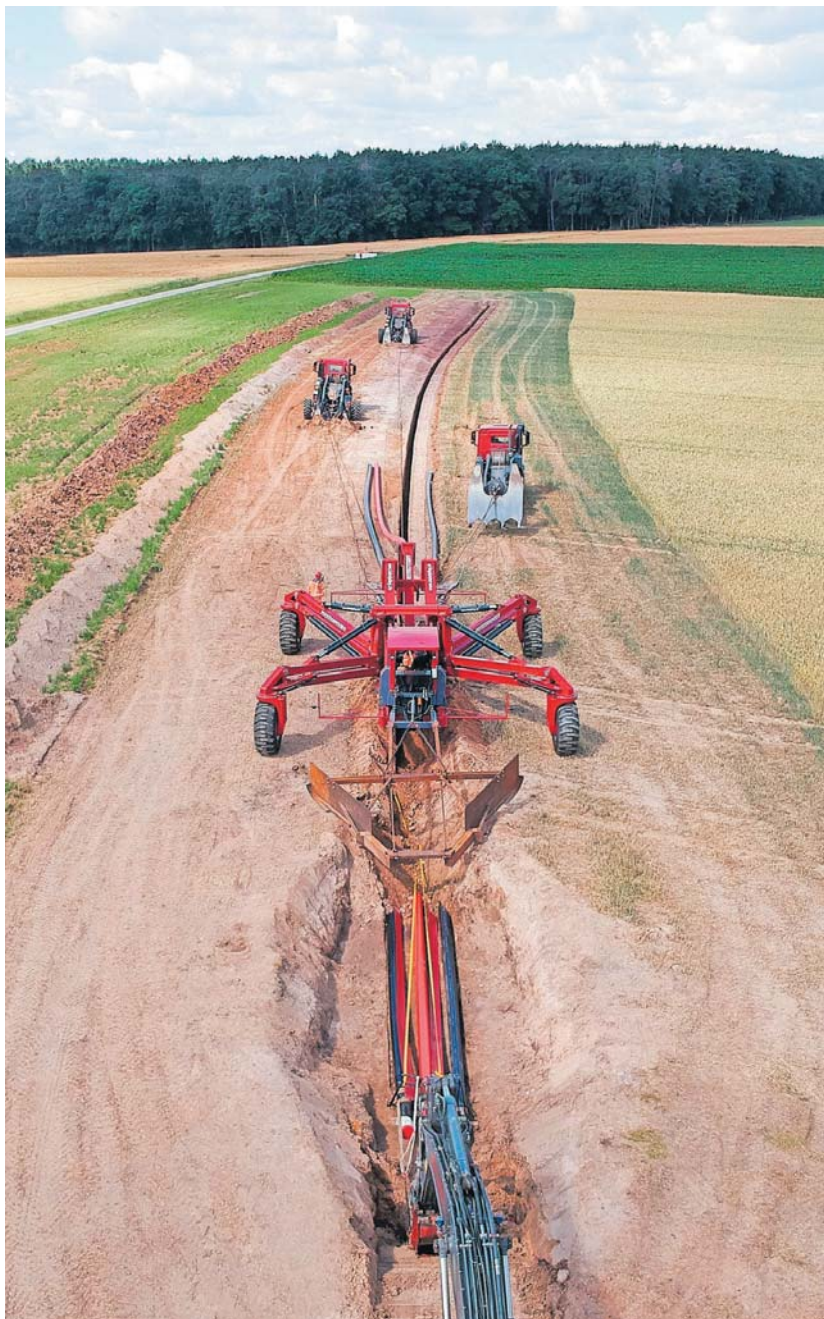
Diese Luftaufnahme vermittelt einen Eindruck der Verlegevorrichtung.
