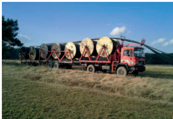
Kabeltransport mit sieben Trommeln.
