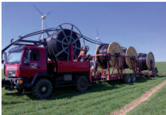
Kabeltransport mit vier Trommeln.
