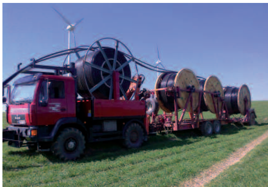
Kabeltransport mit vier Trommeln.
