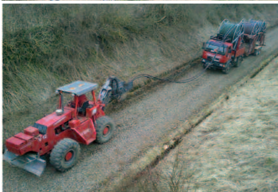
Einpflügen 3 x KSR PE-HD DA 50 mit Trommeltransport.
