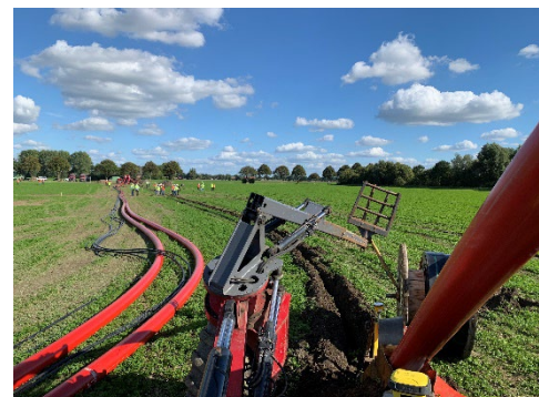
Gepflügte Strecke mit Rohrauslagen neben der Trasse.
