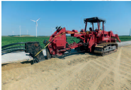
Einpfügen eines Mittelspannungsystems und KSR PE-HD DA 50.
